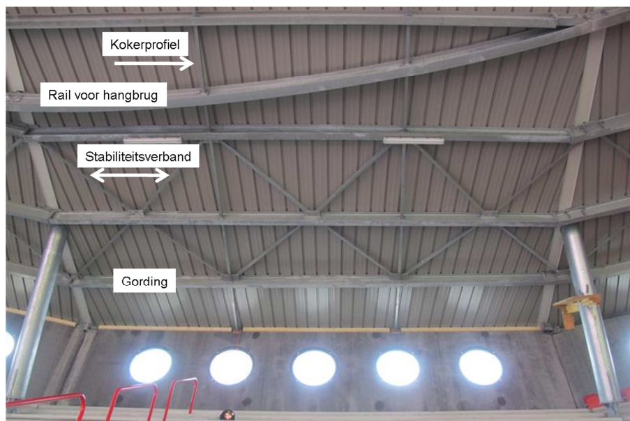
Foto 4.9: Onderaanzicht dakconstructie; gekromde gording is rail voor hangbrug (TNO)
