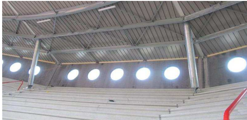
Foto 4.17: Betonnen achterwand (TNO)
