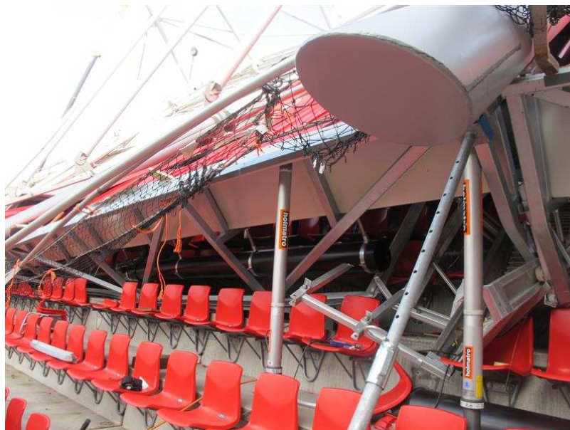
Foto 5.2: Gestut en opgevijseld deel nabij spant 12 (TNO)
