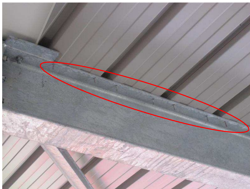
Foto 4.12: Bevestiging van de dakplaten met zelftappende schroeven (TNO)
