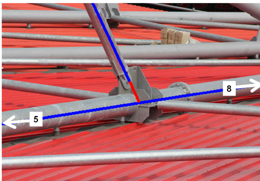
Figuur 6: Modelling excentriciteit ter plaatse van knooppunt 7
