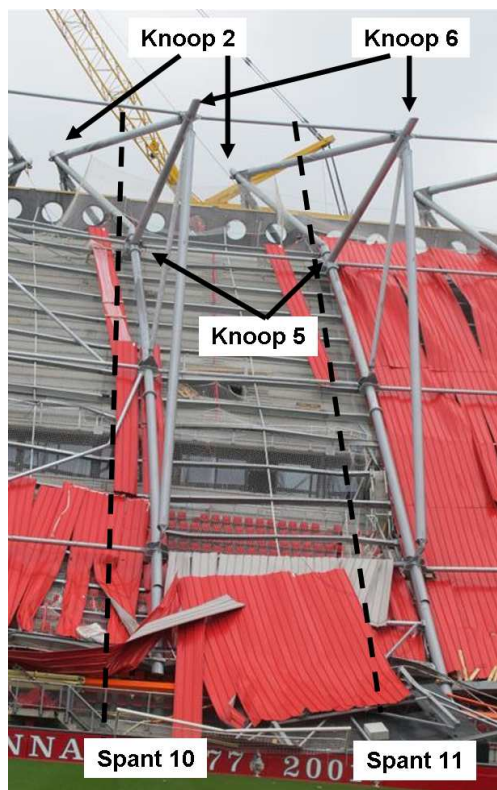
Figuur 5.1: Positionering van de spanten 10 en 11 na de instorting
