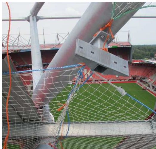
Foto 4.8: Ankerplaat aan spant 11 ten behoeve van bevestiging aan betonnen wandelement (TNO)
