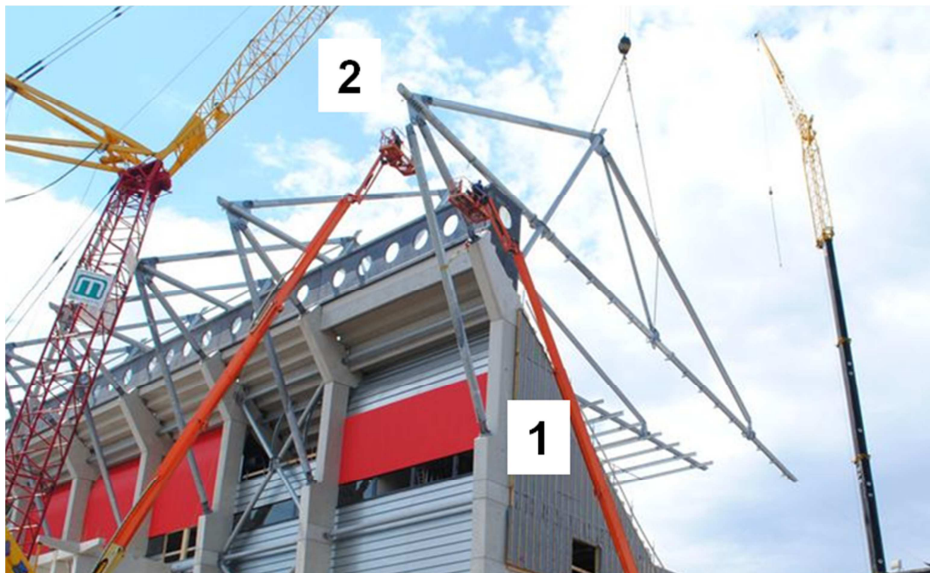
Foto 4.2: Montage spantdeel 1-2, met het samengestelde spant in de kraan [F.051]
