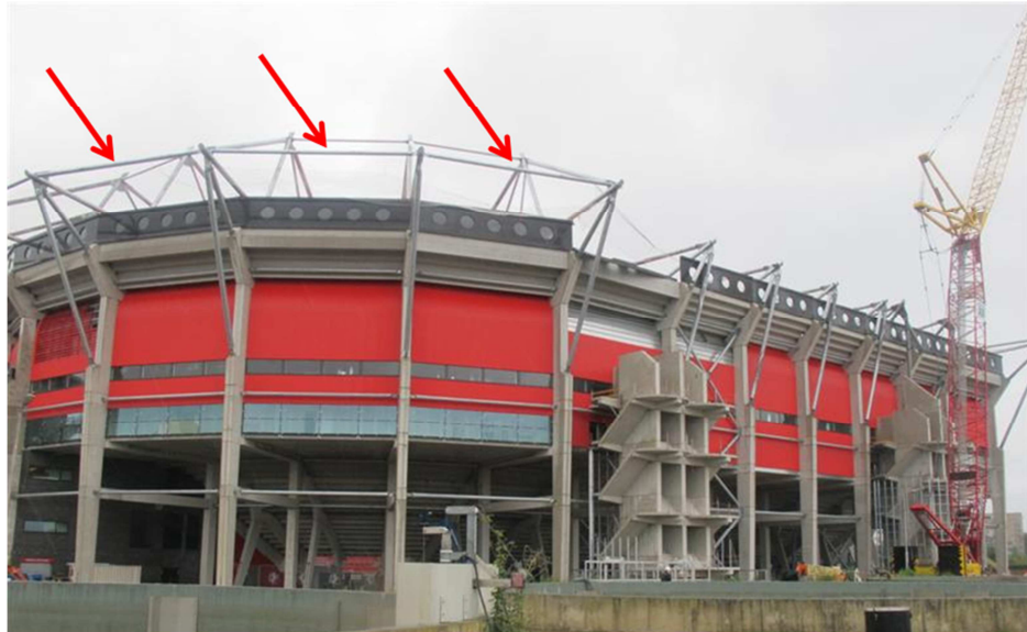
Foto 4.10: Koppelstaven tussen knooppunt 2 van de spanten Z17 – Z20 (TNO)
