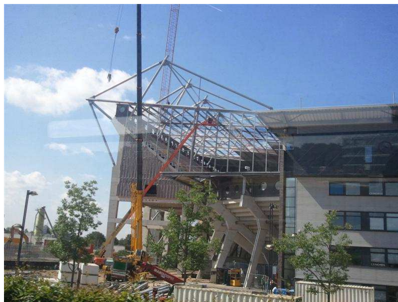
Foto 6.3: Eindwand aan spant Z1 op de ochtend voor de instorting, omstreeks 11.10 uur [F.077]
