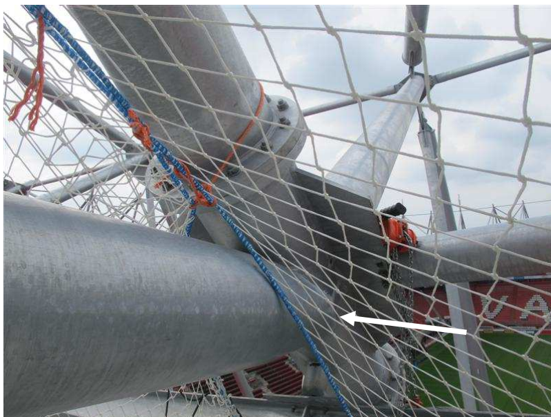
Foto 6.36: Spant 10 met het verbogen deel tussen de knooppunten 4 en 5 (TNO)
