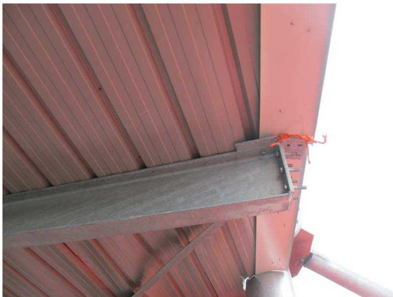
Foto 7.5: Buitenste gording ter plaatse van spant Z20 (TNO)
