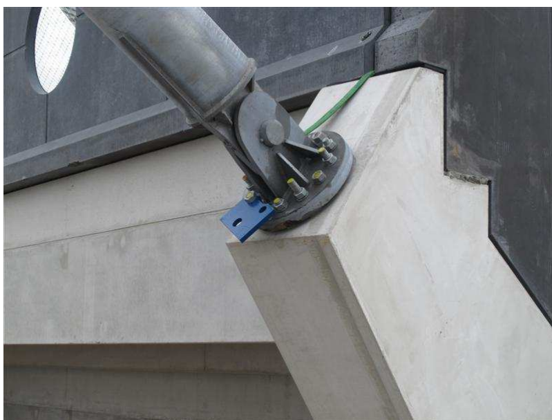
Foto 8.8: Strop aan knooppunt 3 van spant Z1 (TNO)
