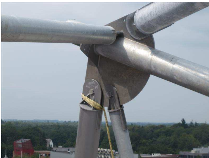
Foto 8.11: Strop om knooppunt 6 van spant 8 (TNO)
