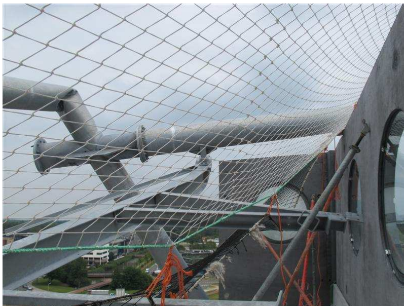
Foto 6.51: Spant Z1 met de losse flensverbinding van het horizontale deel (TNO)
