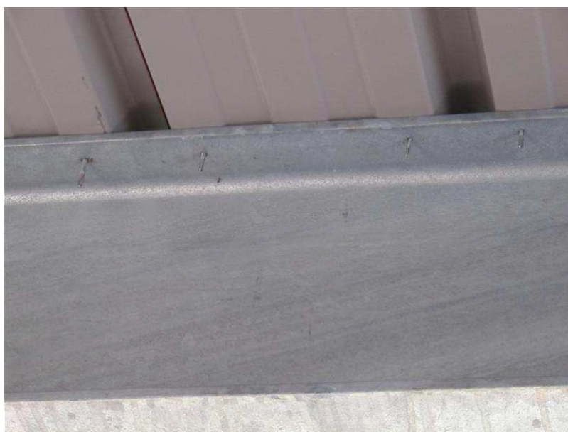
Foto 7.18: Twee zelftappende schroeven per "golfdal" (TNO)
