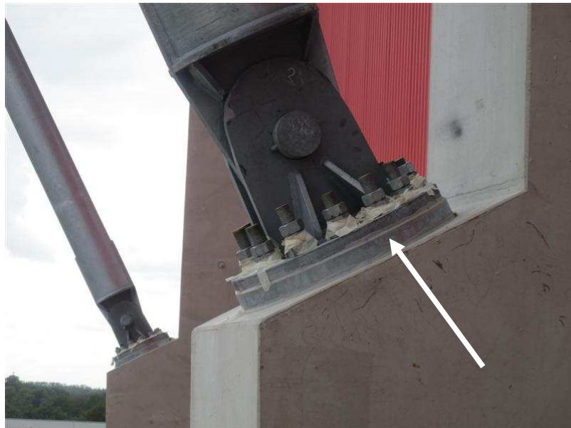
Foto 8.2: Knooppunt 1 ondergoten met gietmortel (TNO)
