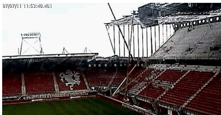
Foto 3.4: CAM 33 – omstreeks dit tijdstip (11:53:48:461) is zichtbaar dat ook de hangbrug aan spant 12 begint te bewegen [F.008]
