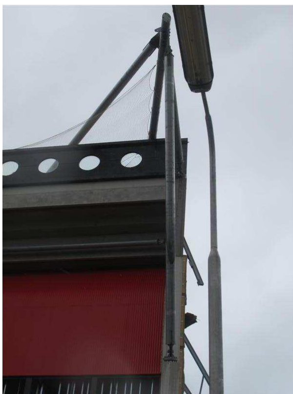
Foto 6.50: Spant Z1 met het gedeeltelijk weggekantelde deel aan de buitenzijde (TNO)
