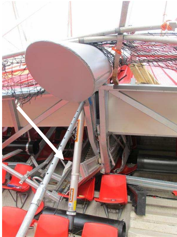
Foto 5.6: Hangbrug aan het binnenste deel overkapping ter plaatse van spant 12 (TNO)
