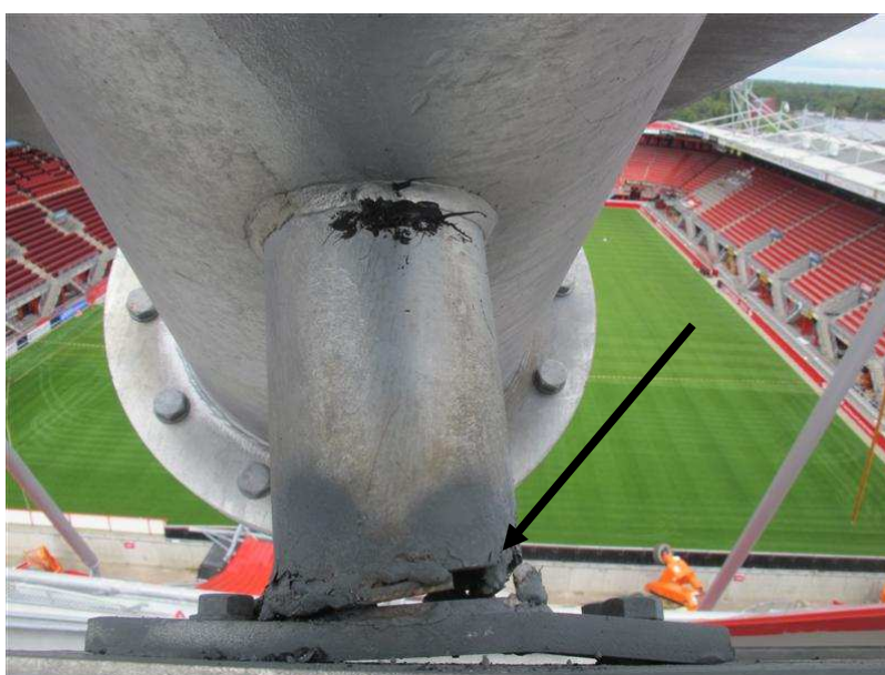
Foto 8.16: Laswerk aan verbinding tussen gording en spant 10, ter plaatse van knooppunt 5 (TNO)
