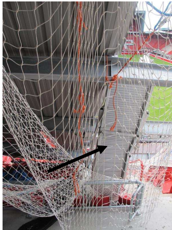
Foto 5.5: Hangbrug aan het binnenste deel overkapping ter plaatse van spant 11 (TNO)
