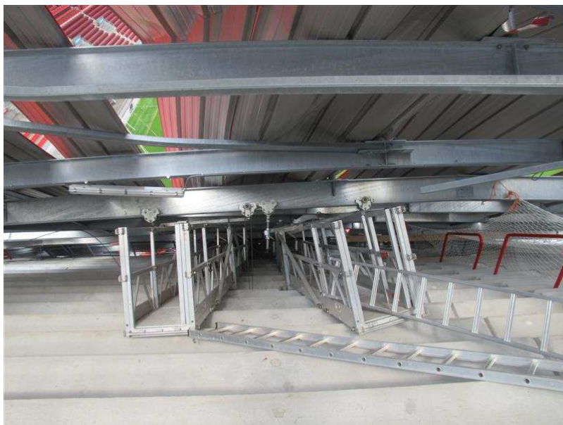
Foto 5.8: Twee hangbruggen aan het buitenste deel van de overkapping ter plaatse van spant 12 (TNO)
