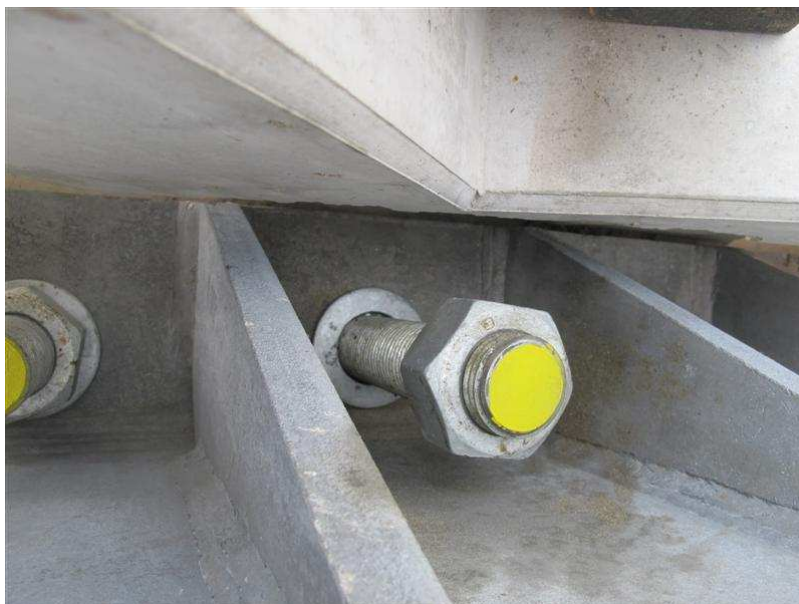
Foto 8.7: Niet aangedraaide moer bij knooppunt 4 van spant 9 (TNO)
