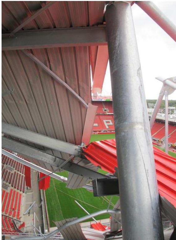
Foto 7.7: Derde en vierde gording vanaf de buitenzijde ter plaatse van spant Z20 (TNO)
