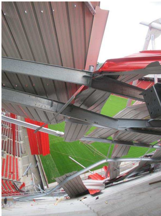
Foto 7.8: Vierde en volgende gordingen vanaf de buitenzijde ter plaatse van spant Z20 (TNO)
