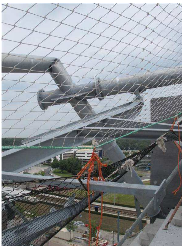
Foto 6.52: Spant Z1 met het weggebogen, verticale deel (TNO)
