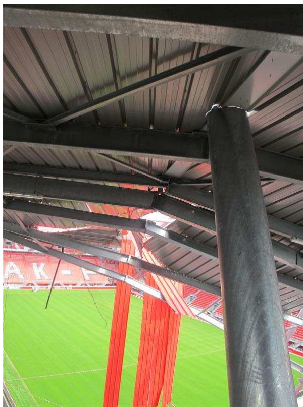
Foto 7.4: Gordingen ter plaatse van spant Z19 (TNO)
