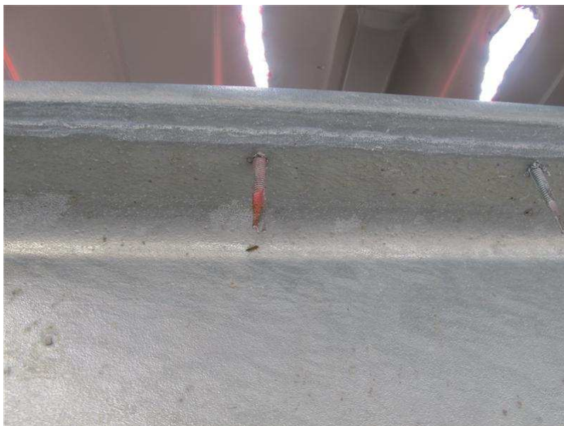
Foto 7.17: Zelftappende schroeven als bevestiging voor de dakplaten (TNO)
