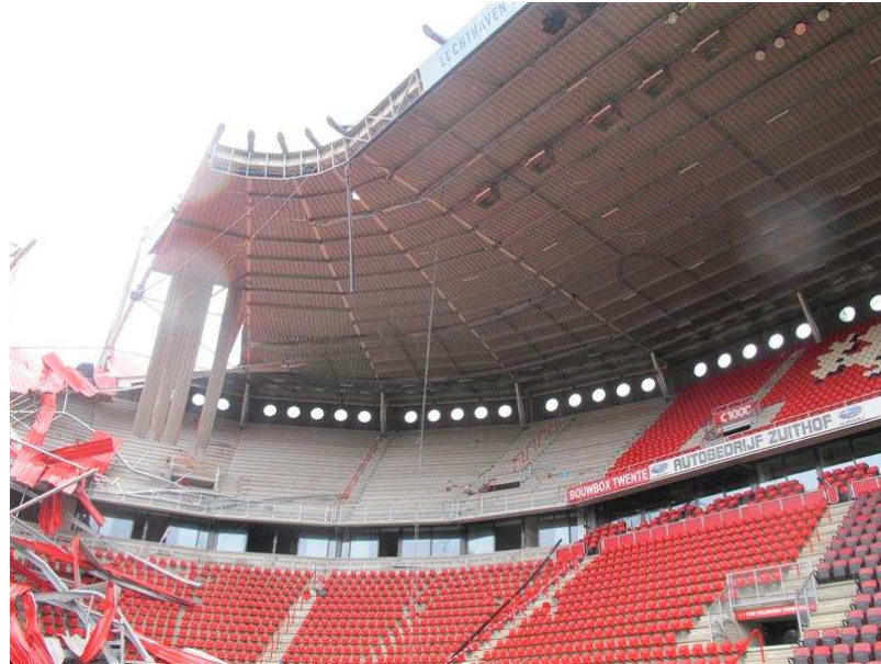
Foto 7.1: Dakconstructie tussen spant Z20 en de L-uitbreiding (TNO)
