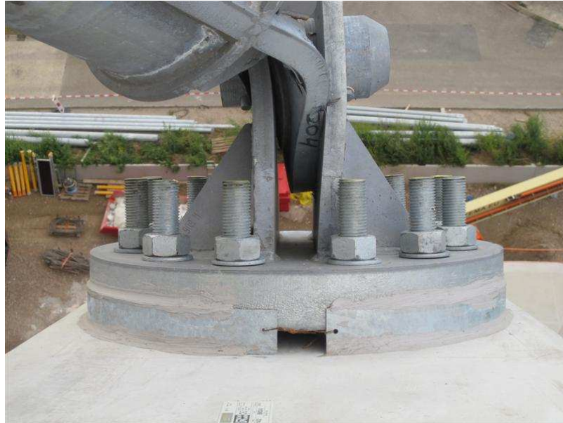
Foto 8.1: Knooppunt 1 gereed om te ondergieten met mortel (TNO)
