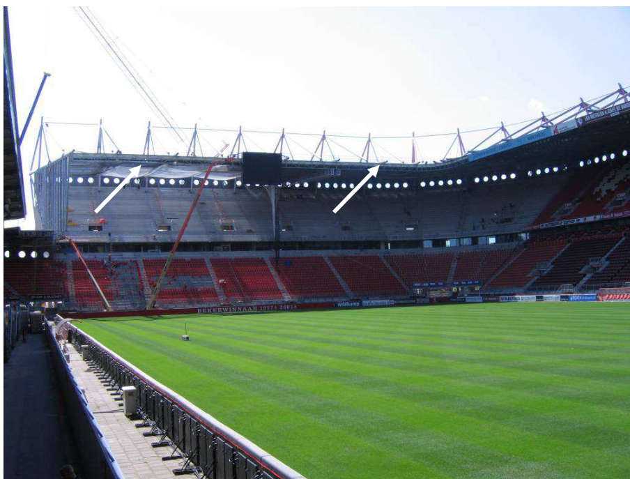
Foto 5.2: Opname ochtend voor de instorting – dakrand aan binnenzijde is gemonteerd [F.033]
