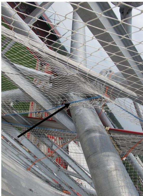
Foto 6.43: Spant 9 met het verbogen deel tussen de knooppunten 4 en 5 (TNO)
