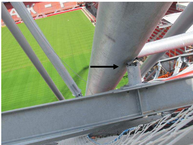
Foto 7.13: Bezweken verbinding van gording met spant (TNO)
