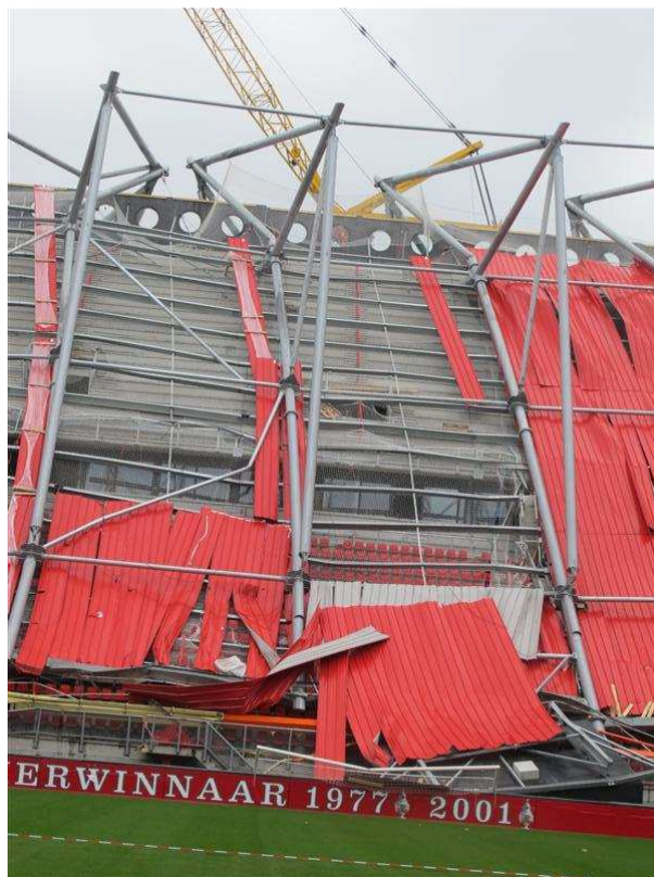
Foto 7.22: Dakplaten tussen de spanten 9 en 11 (TNO)
