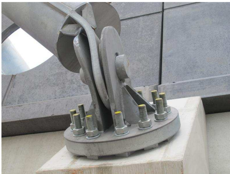
Foto 8.6: Knooppunt 3 van spant 8 – voetplaat op stelblokjes, zonder gietmortel, en niet vervormd (TNO)
