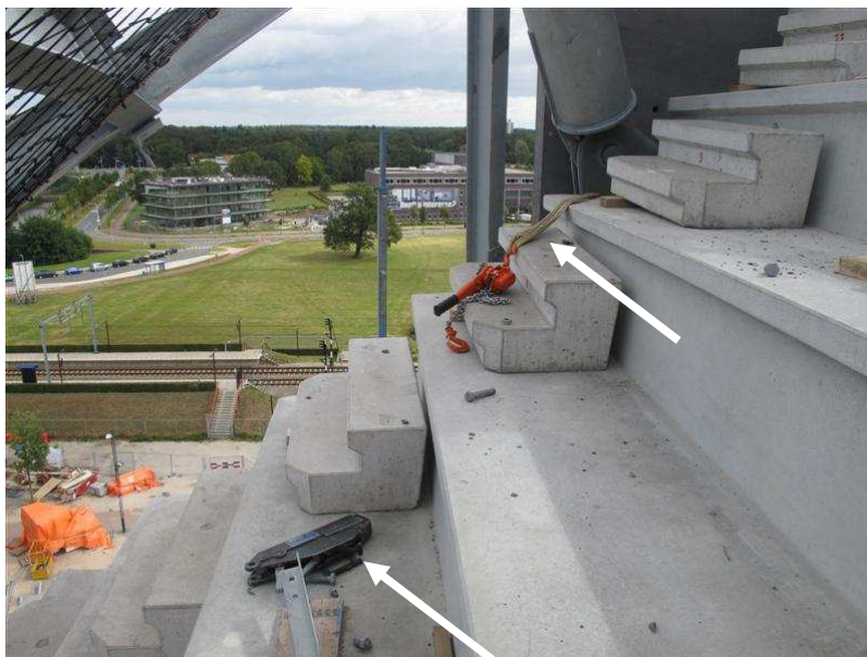
Foto 8.10: Strop met handtakel en tirfor ter plaatse van knooppunt 4 van spant Z1 (TNO)
