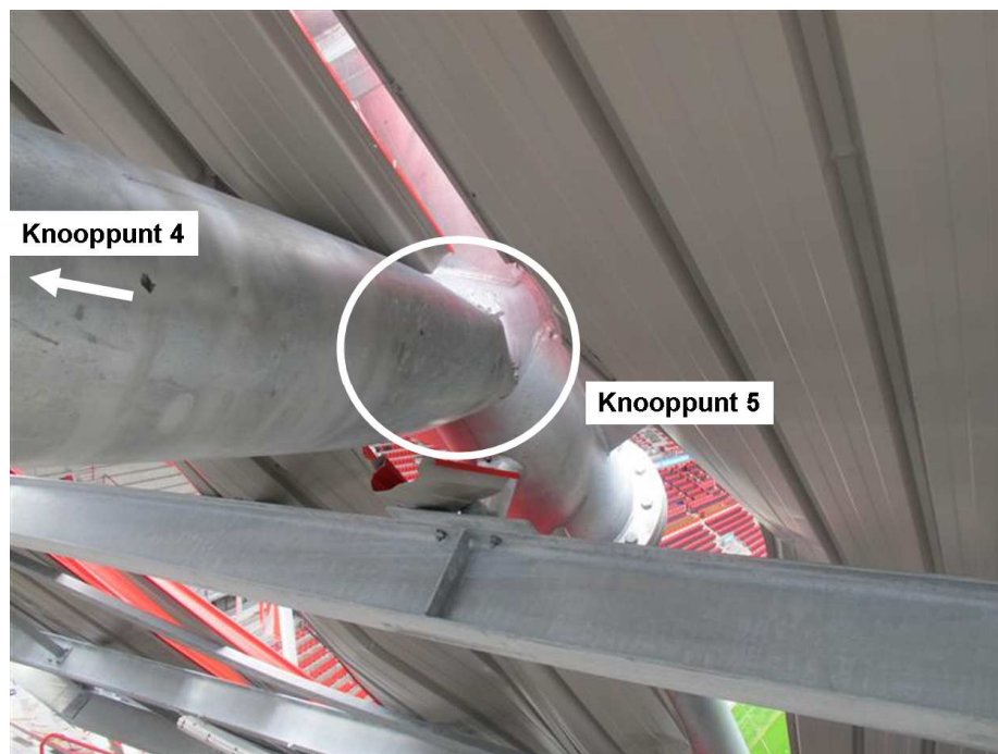
Foto 6.23: Spant 12 met het verbogen deel tussen de knooppunten 4 en 5 (TNO)
