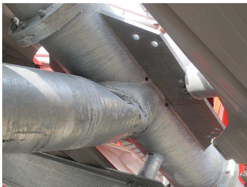
Foto 6.16: Spant 13 met het verbogen deel tussen de knooppunten 4 en 5 (TNO)
