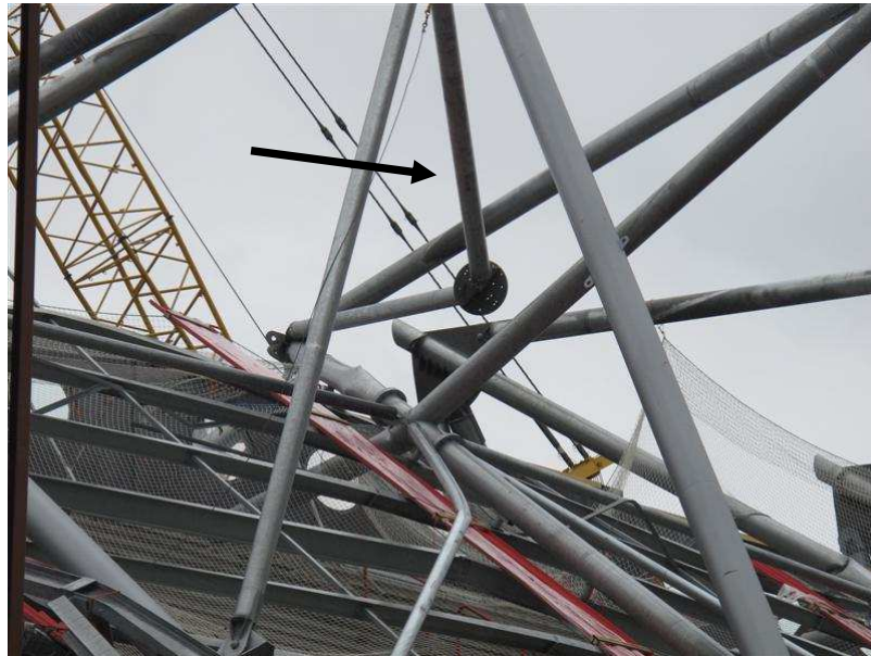
Foto 6.7: Halverwege de lengte uitgeknikte staaf van het verticaal georiënteerde stabiliteitsverband tussen de spanten 8 en 9 (TNO)
