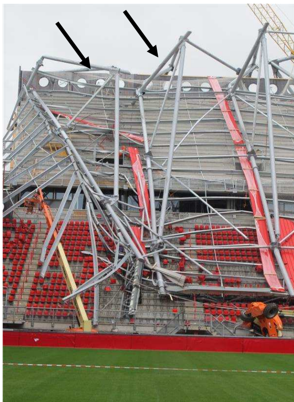
Foto 6.44: De spanten Z1 en 8 na de instorting (TNO)
