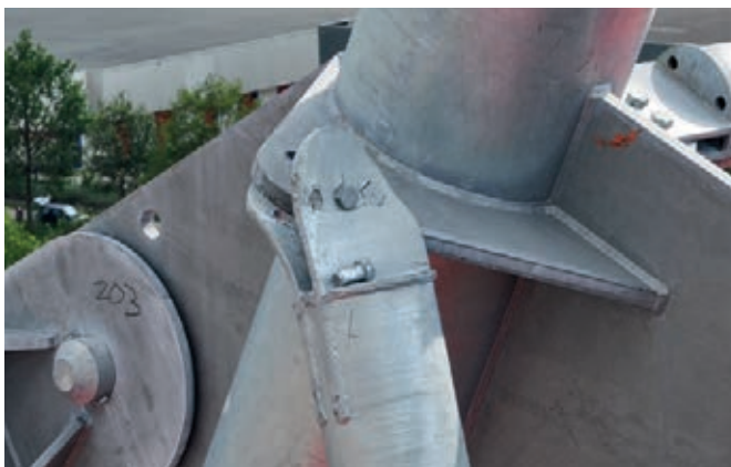
Figuur 26: Schadebeeld verbindingen van de nok koppelbuis tussen spant Z20 en 13, links aan spant Z20
