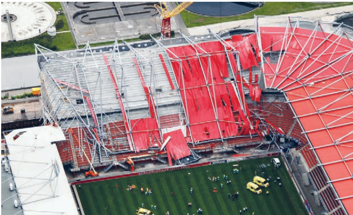
Figuur 1: Bovenaanzicht van het ingestorte dak 9
