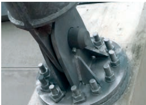
Figuur 4: Scharnierende oplegging 12
