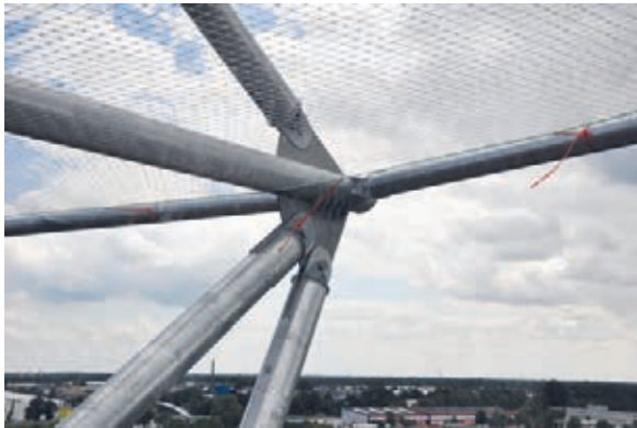
Figuur 5: Twee knooppunten/knoopplaten (punt 2 en 7)
