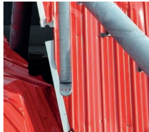
Figuur 26: Schadebeeld verbindingen van de nok koppelbuis tussen spant Z20 en 13, links aan spant Z20
